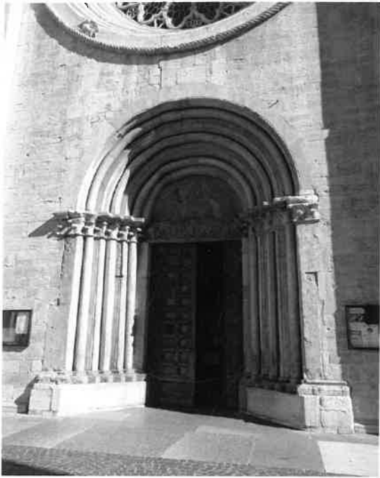
Fig. 38, Trento, duomo, portale di facciata
