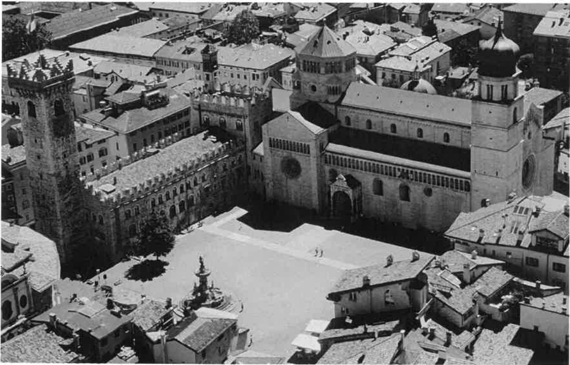
Fig. 40, Trento, veduta aerea del duomo
