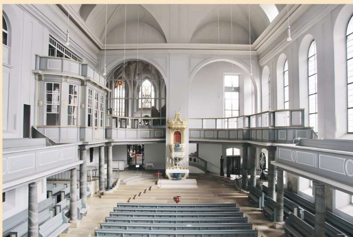
San Gumberto, vista interna · St. Gumbertus, Innenansicht
